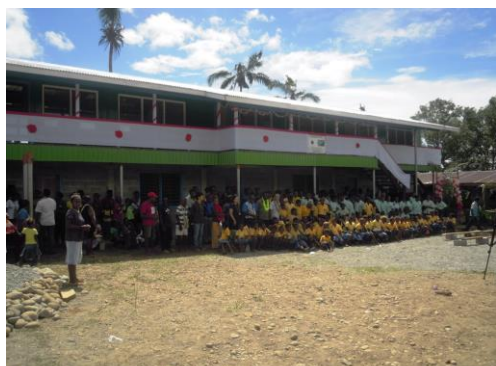
完成した新校舎
