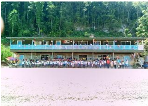
完成した新校舎
