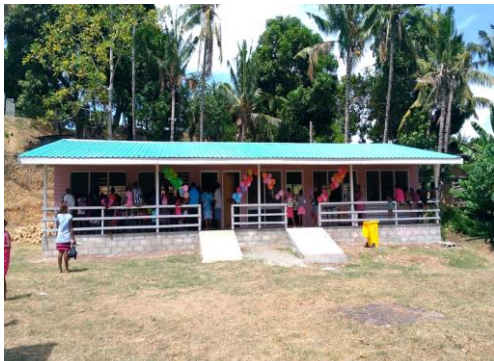
完成した新校舎
