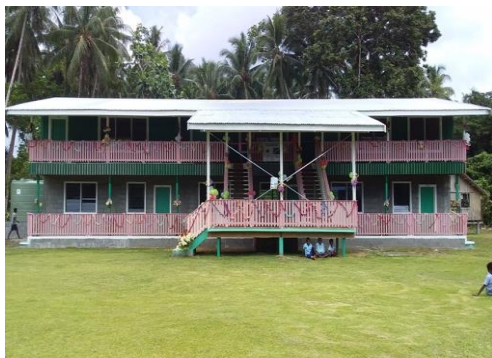
完成した新校舎
